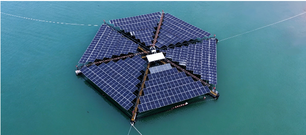
全球首个张弦浮岛式光伏发电平台“渤海 1 号”在天津临港成功示范
