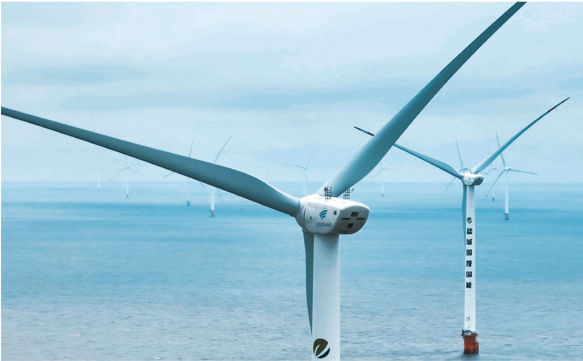
安装有金风科技机组的江苏盐城国投大丰 H5# 海上风电场 (创造全国首个海上风电单月零故障运行纪录)
