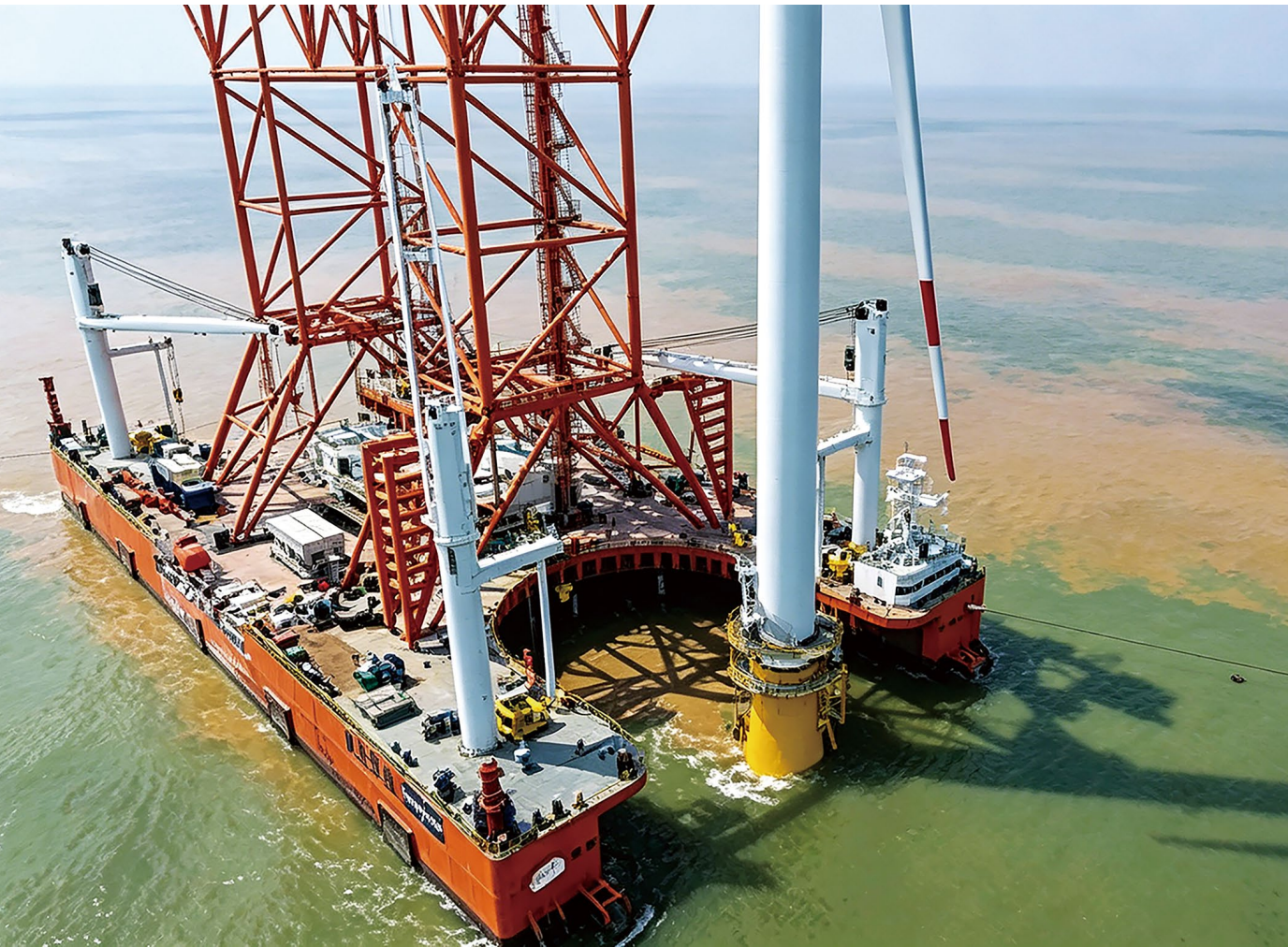
海上风电基础整体沉放和调平
