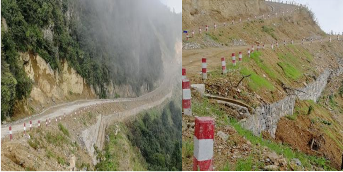
场内道路挡土墙施工情况
