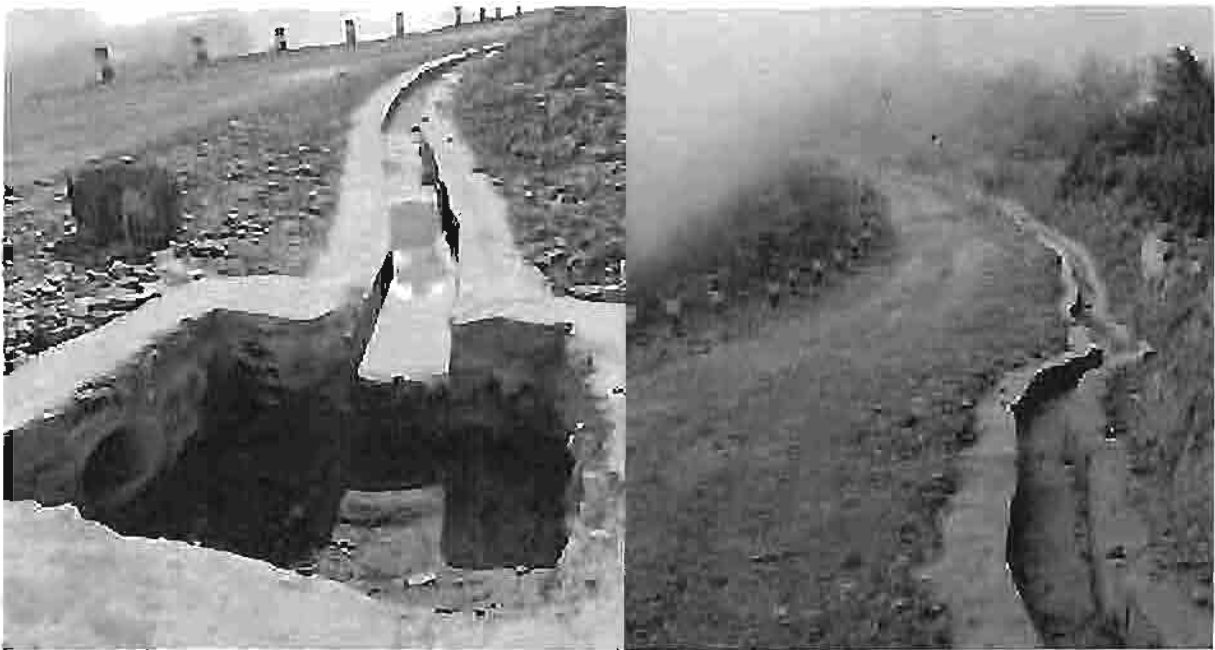
现场施工排水沟质量
