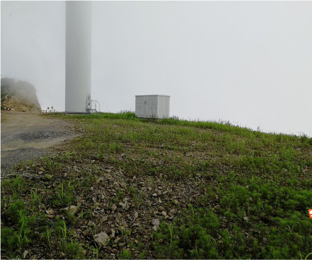
风机机位平台及箱变植被恢复情况
