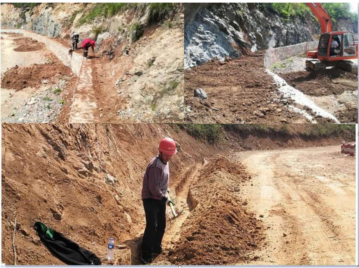
2018 年度对沿路排水沟进行清理及上边坡覆土绿化
