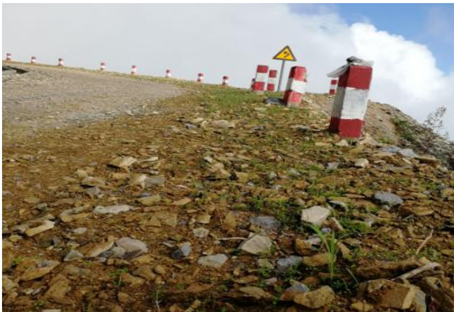
道路外侧绿化与标识牌，其他施工区域也进行植被绿化恢复
