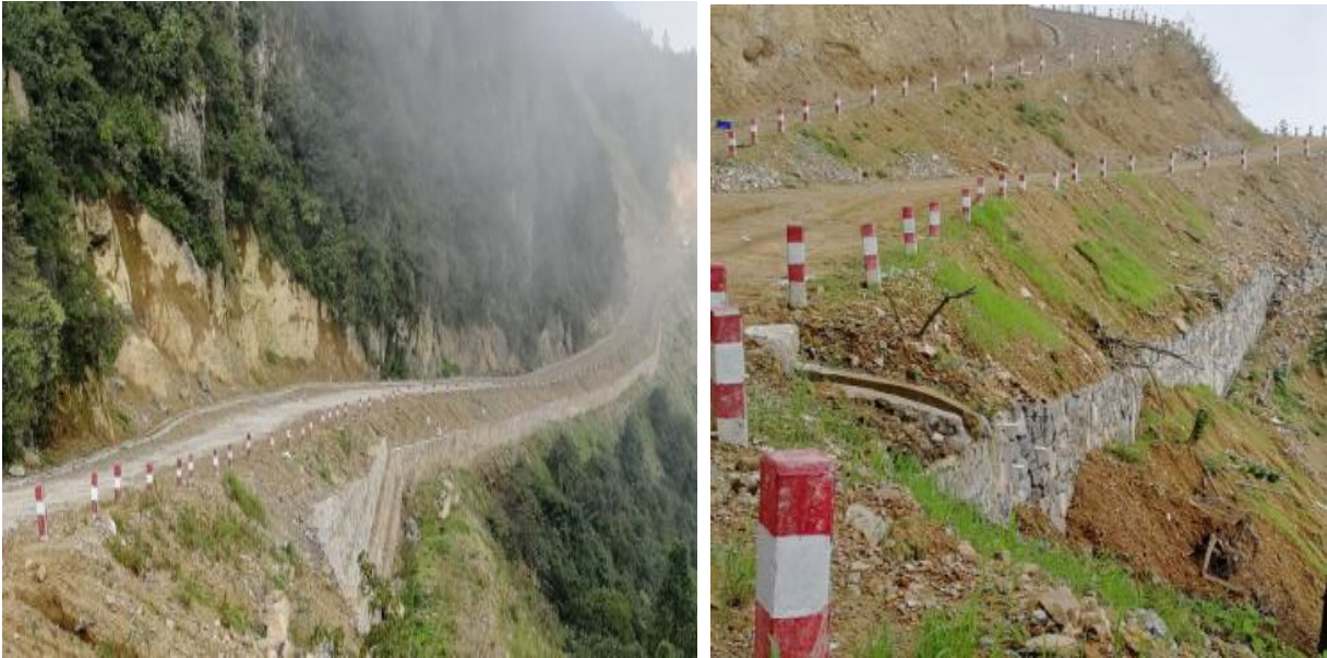
场内道路挡土墙施工情况
