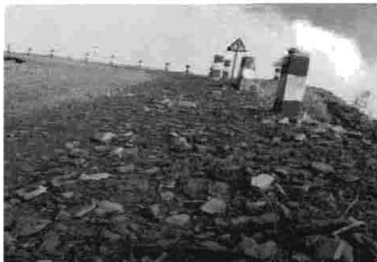
道路外侧绿化与标识牌，其他施工区域也进行植被绿化恢复
