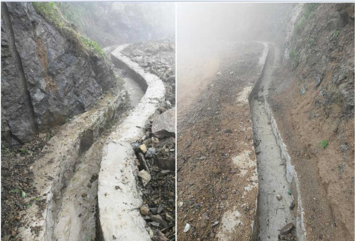
2017年度砌筑的排水沟，2018年进行排水沟清理
