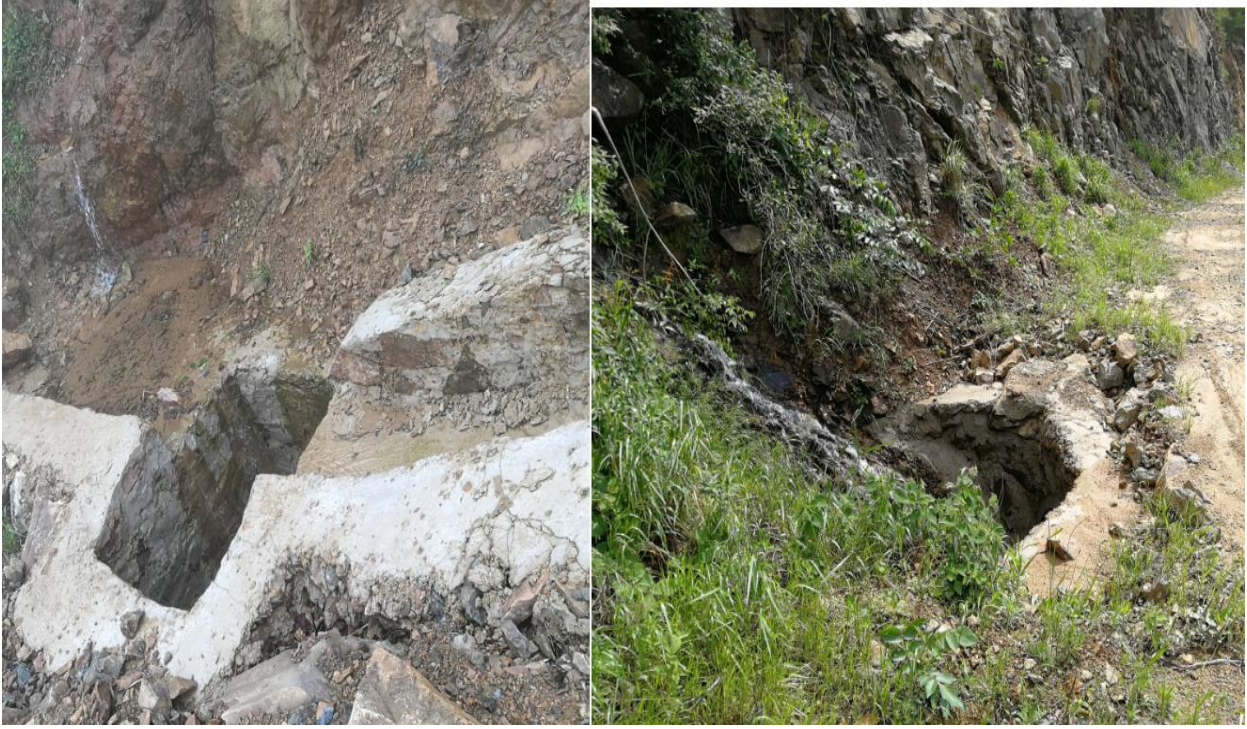
18年4月施工现场的沉砂池及植被绿化情况
