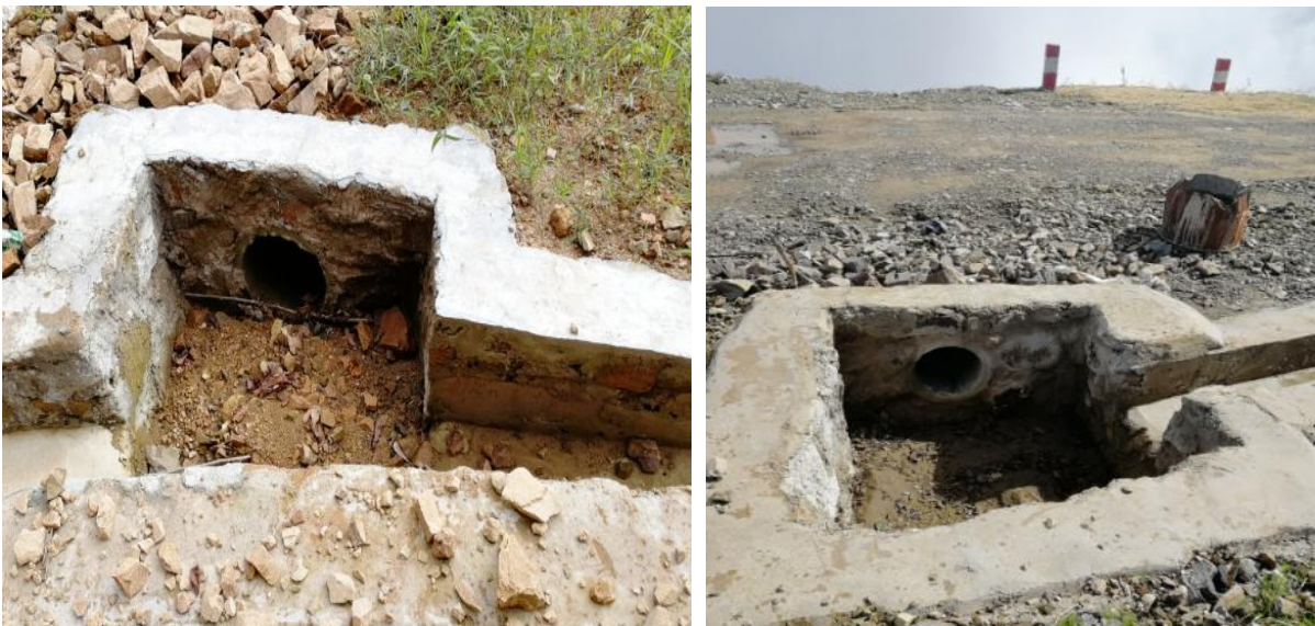
施工现场的沉砂池
