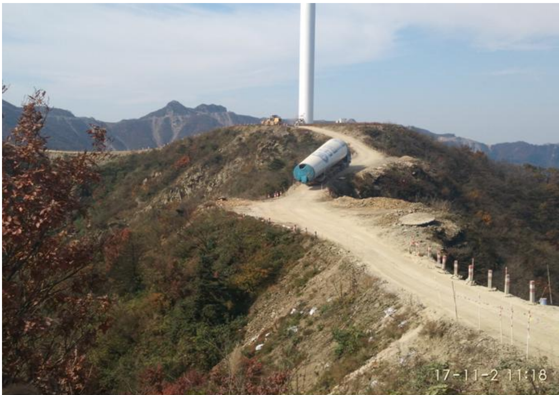
舒城项目大件设备运输，部分排水沟等大件运输结束后开始
