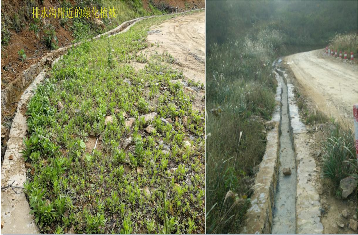
2018 年现场施工排水沟质量
