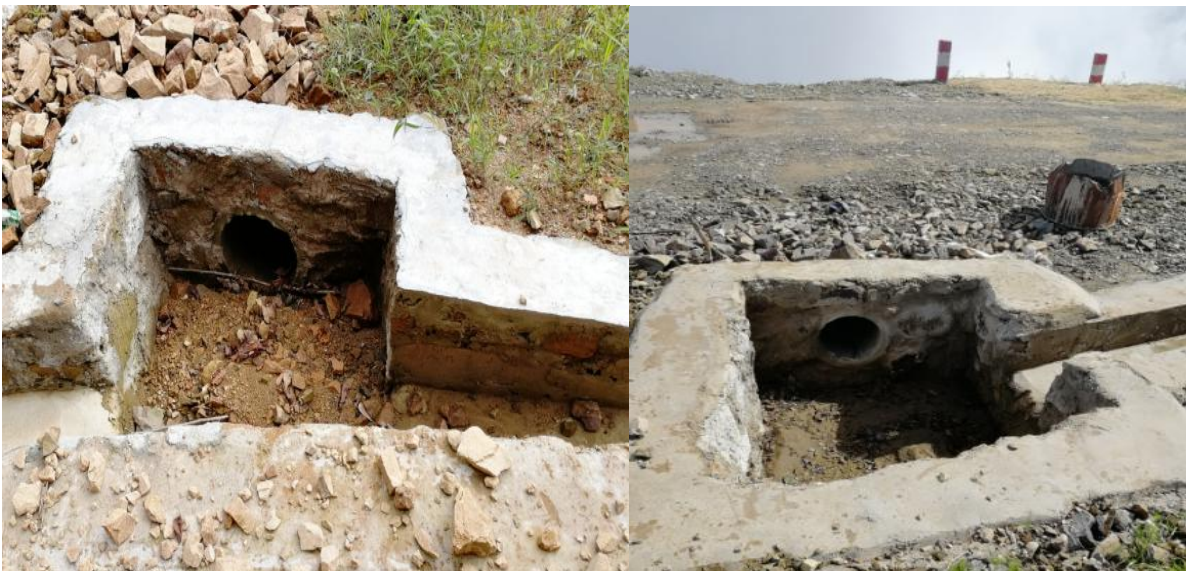
施工现场的沉砂池
