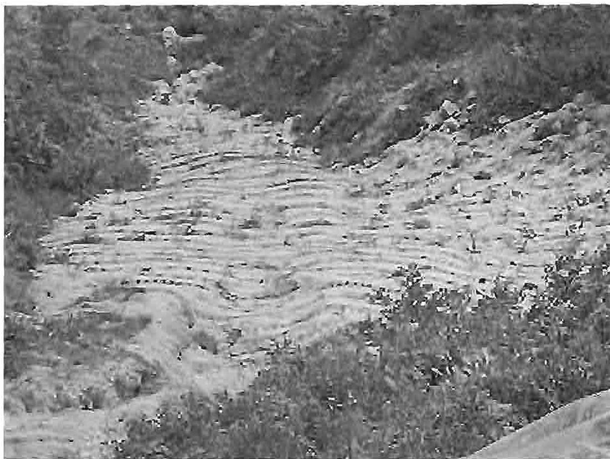
下边坡复绿施工情况
