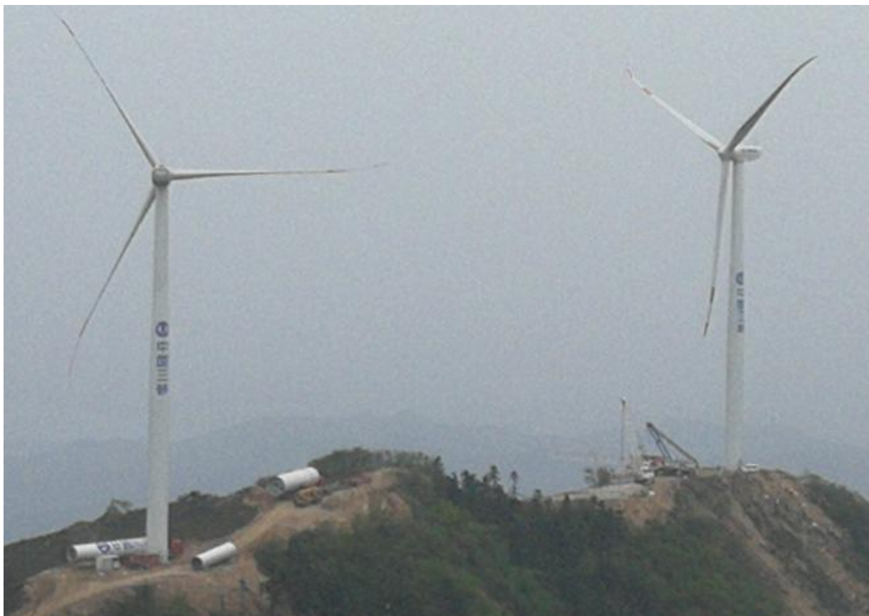
舒城项目处于施工吊装期间
