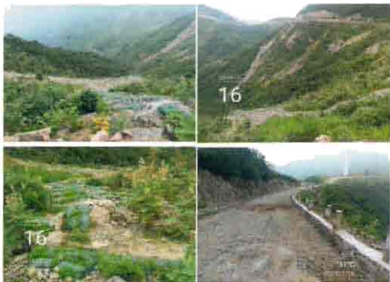
下山边坡主体施工，原播草籽种子均已发芽，边坡上修排水沟建设
