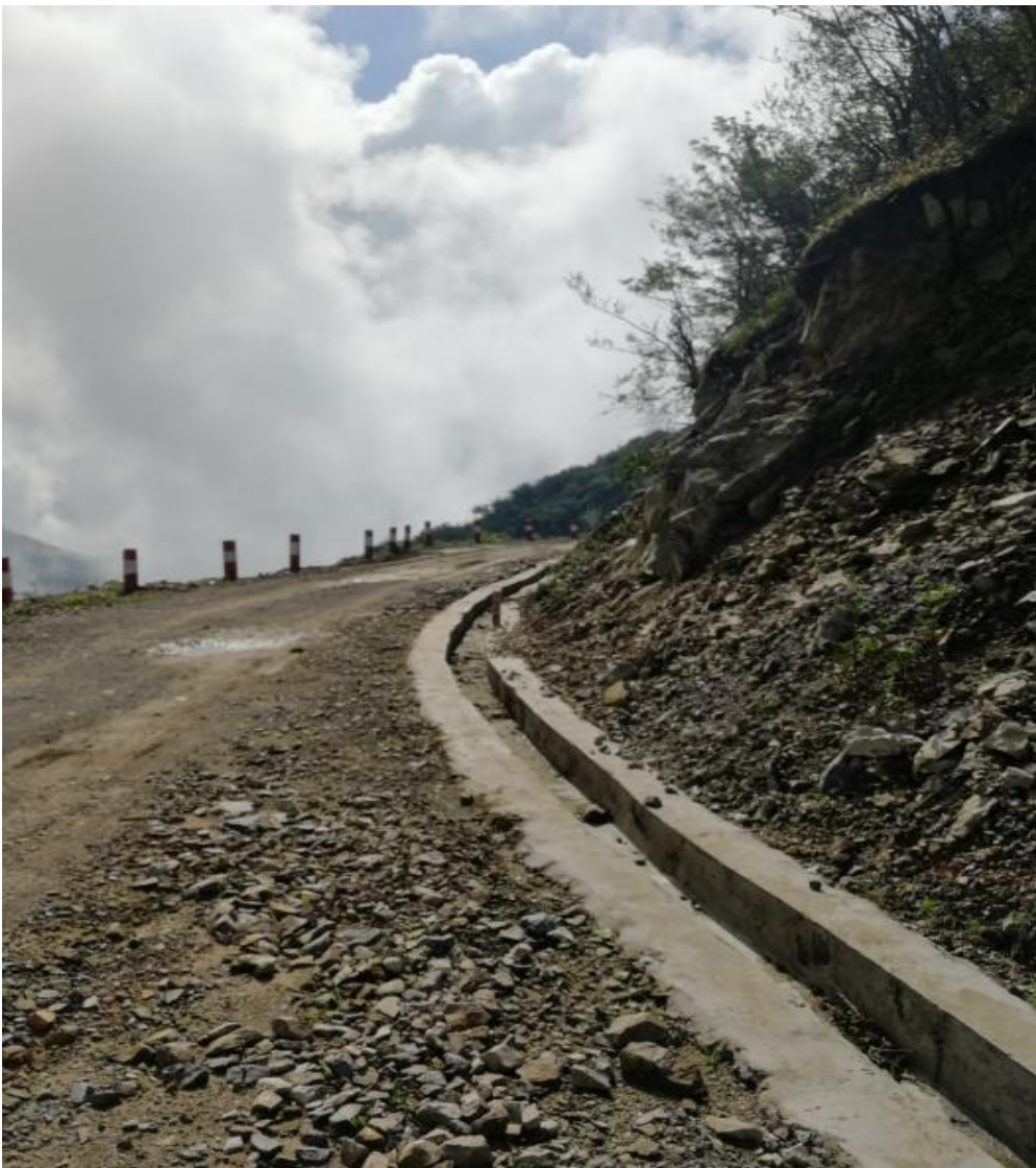
现场施工排水沟质量
