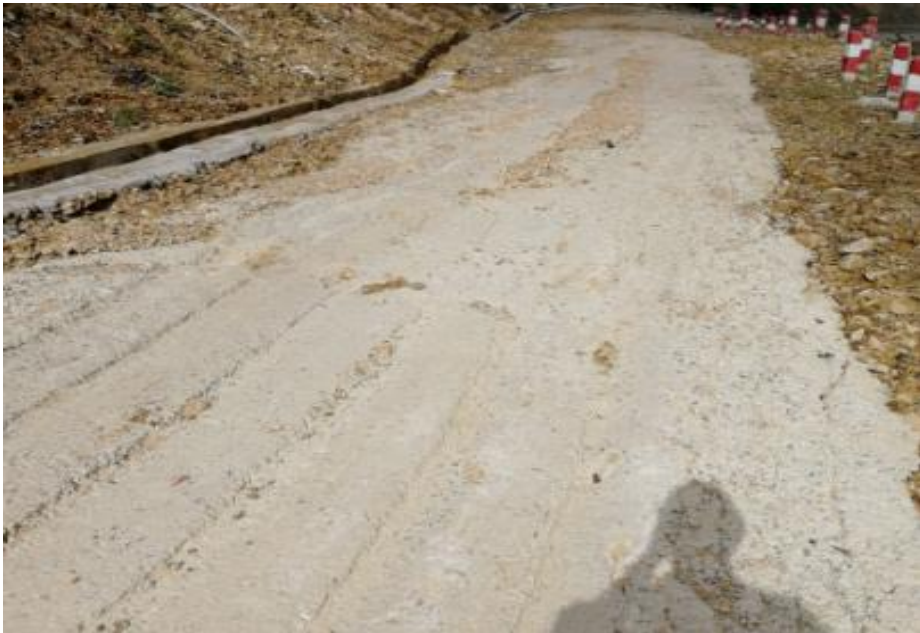
道路路面受雨水冲刷的地方，浇筑混凝土路面，内侧靠山体侧砌筑排水沟，外侧增设防护桩
